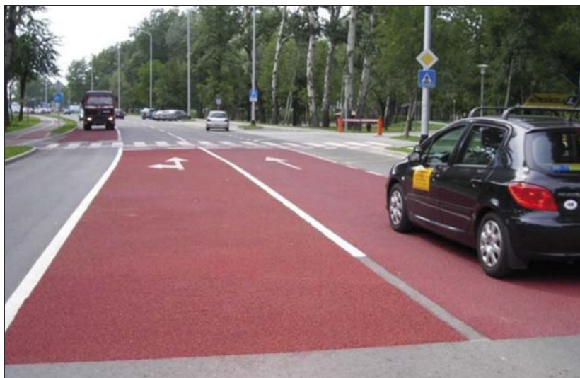
Slika 9. Pješački prijelaz s crvenim asfaltom kao upozorenjem na prilazu bilježenom pješačkom prijelazu
