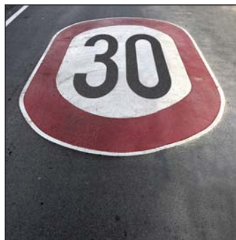
Slika 14. Oznaka na kolniku H45 – „ograničenje brzine“ izvedena kao umjetna izbočina za smirivanje prometa
