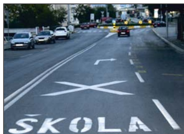
Slike 26. - 30. Malo kružno raskrižje kao mjera za smirivanje prometa, izvedeno u Splitu kod OŠ Ravne Njive od montažnih elemenata uz odgovarajuće okomite i vodoravne prometne znakove
