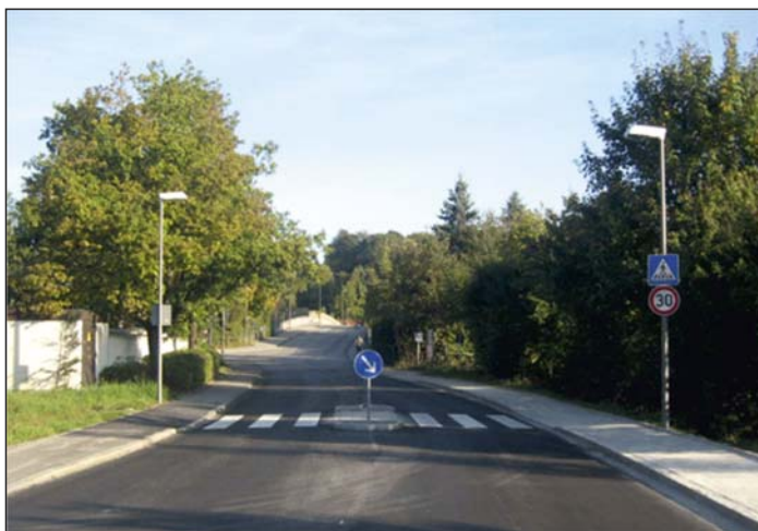
Slika 23. Prometni otok na sredini kolnika kao mjera za zaštitu pješaka i smanjenje brzine kretanja vozila
