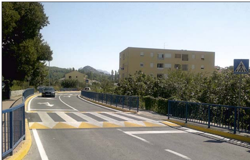
Slika 19. Uzdignute plohe za smanjenje brzine s obilježenim pješačkim prijelazom i ogradama za usmjeravanje i zaštitu pješaka
