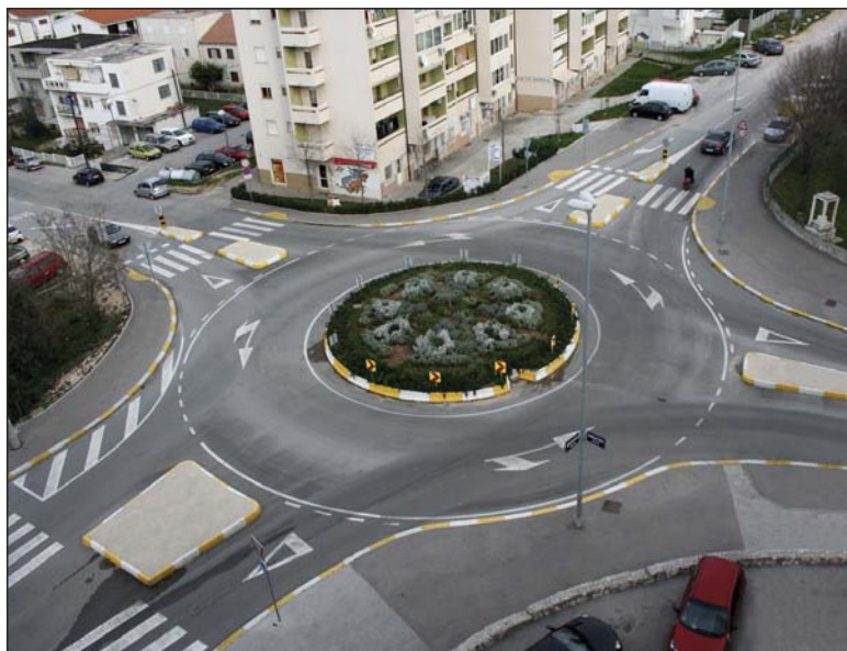
Slike 26. - 30. Malo kružno raskrižje kao mjera za smirivanje prometa, izvedeno u Splitu kod OŠ Ravne Njive od montažnih elemenata uz odgovarajuće okomite i vodoravne prometne znakove
