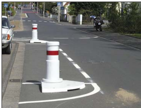
Slika 21. Suženje kolnika na jednoj strani, oblikovano vodoravnom prometnom signalizacijom i prometnom opremom u obliku stupova, kao mjera za smanjenje brzine kretanja vozila
