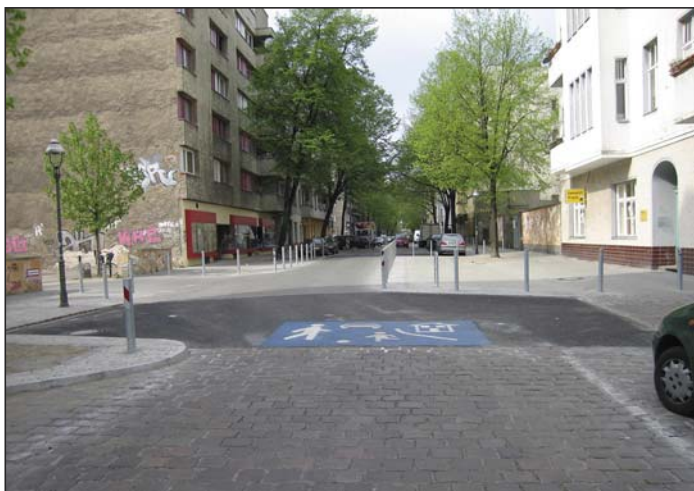
Slika 24. Vodoravna devijacija na kolniku u području smirenog prometa - gdje se ne smije voziti brže od brzine hoda pješaka jer je dječja igra svugdje dopuštena, označenog oznakom C25 na kolniku
